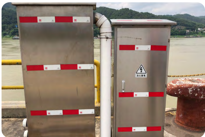
紫金村码头岸电设施 图/自然田
